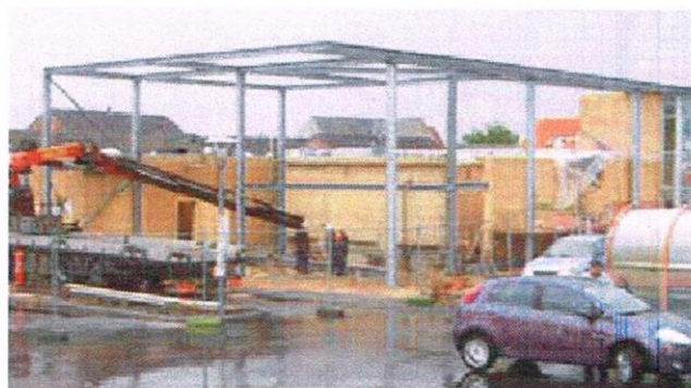
ENVO-DAN har leveret stålkonstruktionen i forbindelse med en tilbygning til SuperBrugsen i Brørup.
